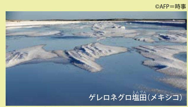
ゲレロネグロ塩田(メキシコ) 太陽の熱と風のおかげで水分を蒸発させて塩をつくります。
